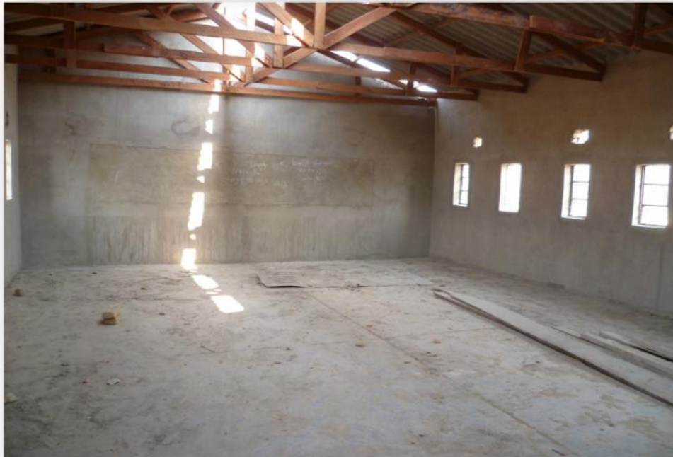
4. Block innen komplett verputzt
